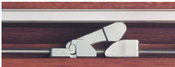
Mecanismo de seguridad antielevación en la hoja corredera
